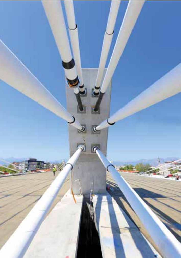
ÇALLI KÖPRÜSÜ | ANTALYA/TÜRKİYE Ekstradoz / Eğik Askı Metodu ÇALLI BRIDGE | ANTALYA/TURKEY Extradosed / Stay Cable Method
