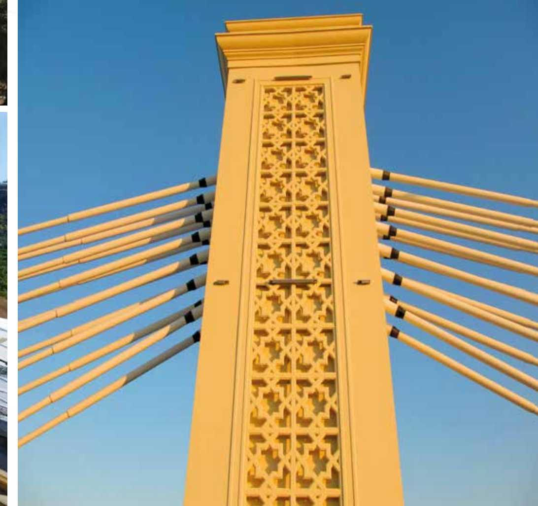
MERDEKAN KÖPRÜSÜ | AZERBAIJAN Ekstradoz / Eğik Askı Metodu MERDEKAN BRIDGE | AZERBAIJAN Extradosed / Stay Cable Method
